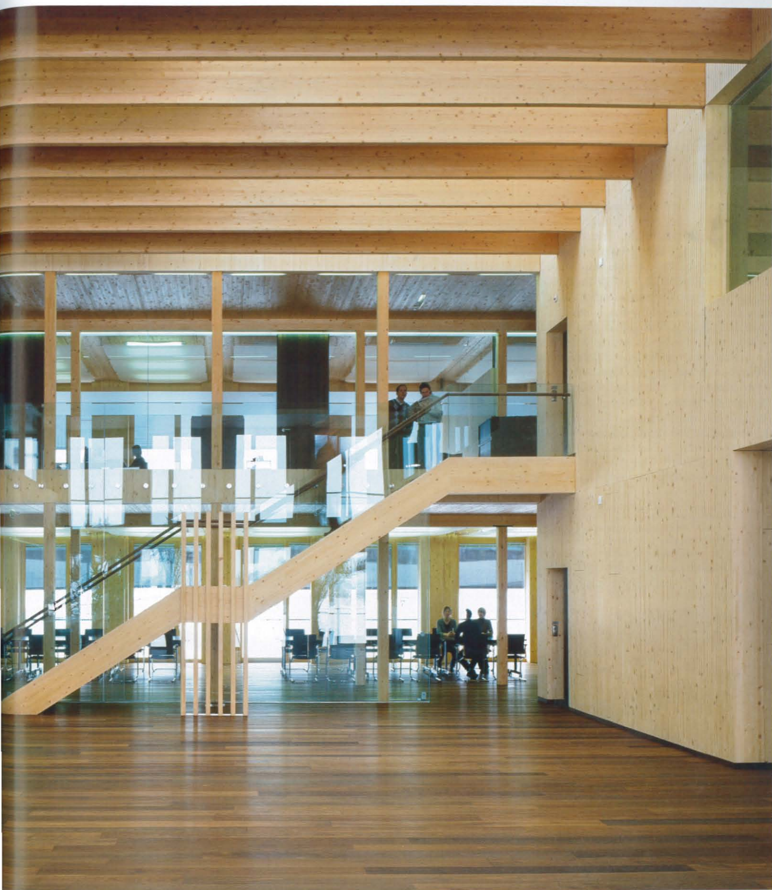
Unerwartet großzügig: zweigeschossige Eingangshalle und Foyer. Eine kräftige Schattenfuge trennt die beiden Holzarten Fichte und geräucherte Eiche.
