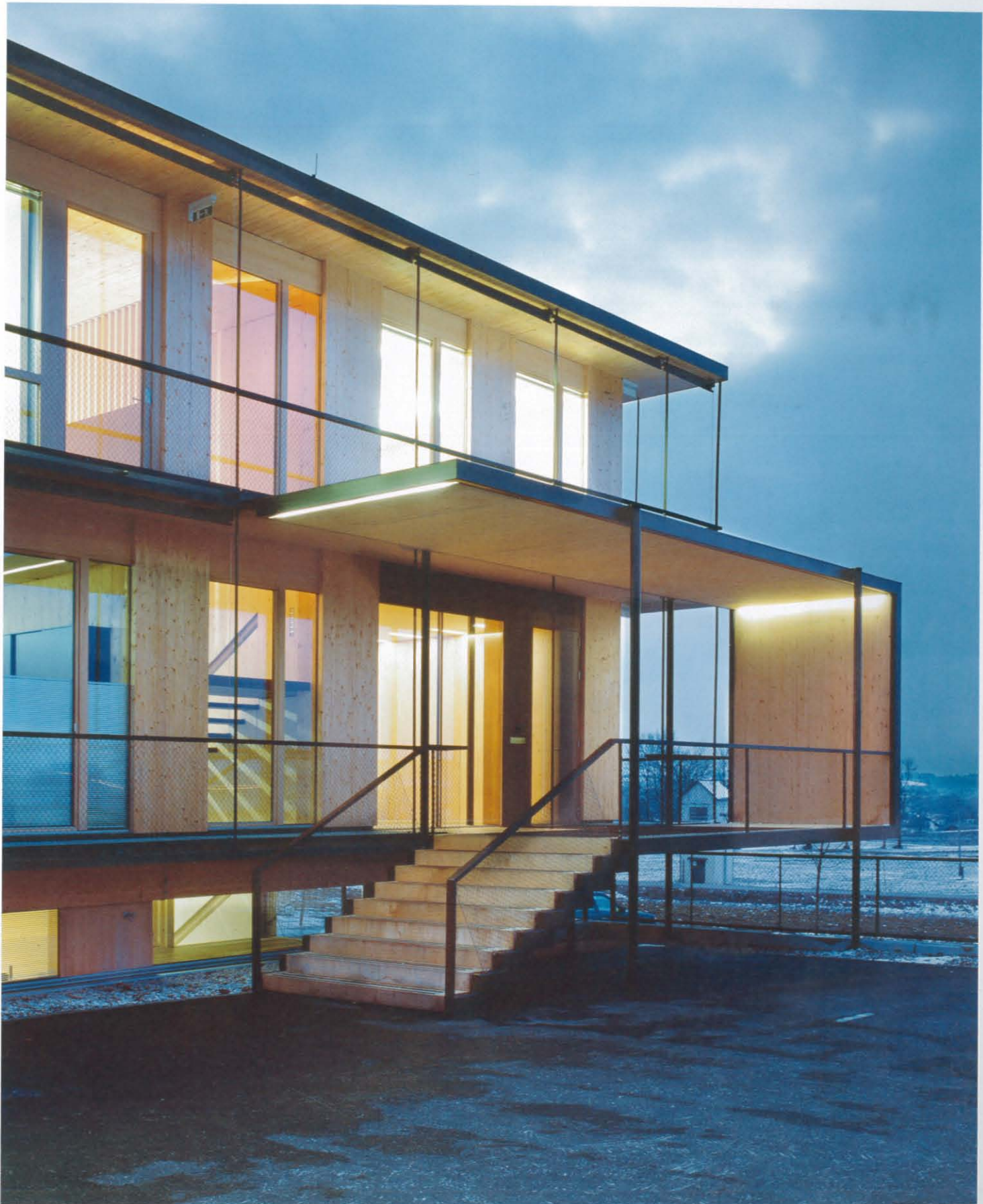
Wirtschaftlich und flexibel: Die Architekten verwendeten das Fichtenbrettschichtholz aus der Unternehmensproduktion und setzten es um in vorgefertigte, massive Tragstrukturen, die keine Verkleidung benötigen. Oben: Nebeneingang auf der Ostseite
